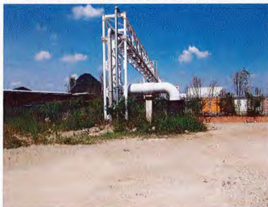
站场建设区现状（二）
