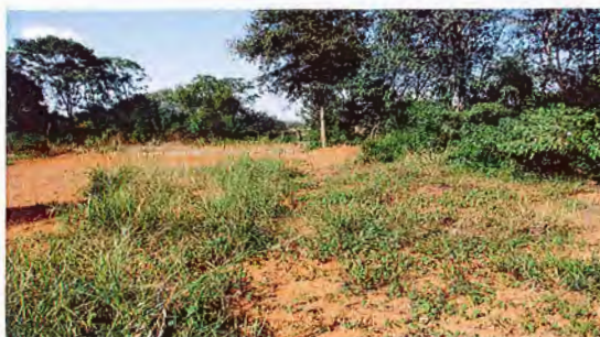
管道作业带区（桂梧高速侧）撒播草籽绿化 （一）
