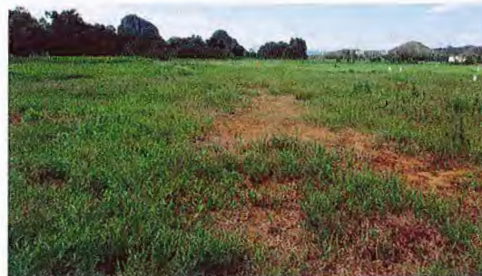
管道作业带区（草地）绿化恢复（二）
