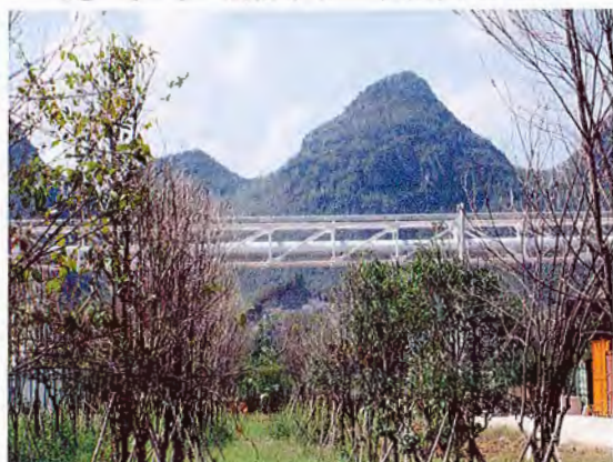
站场建设区现状（一）
