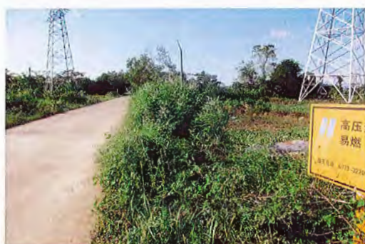
施工便道区撒播草籽绿化恢复（一）
