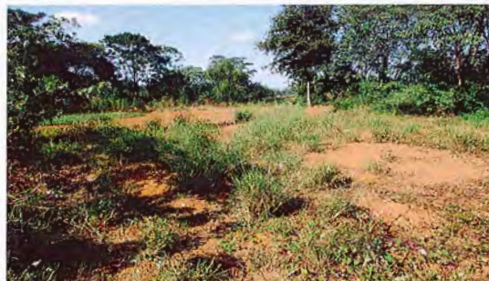
管道作业带区（桂梧高速侧）撒播草籽绿化 （二）
