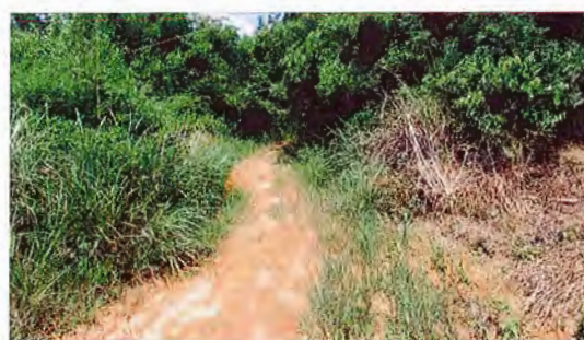
施工便道区撒播草籽绿化恢复（二）
